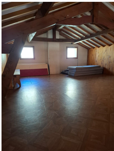
La mezzanine sur la salle des Fêtes
